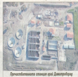
Пречиствателната станция край Димитровград
