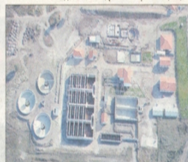
Пречиствателната станция край Димитровград
